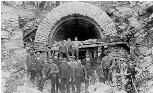
Arbeiter beim Bau des knapp 400 m langen Ahrdorfer Tunnels
